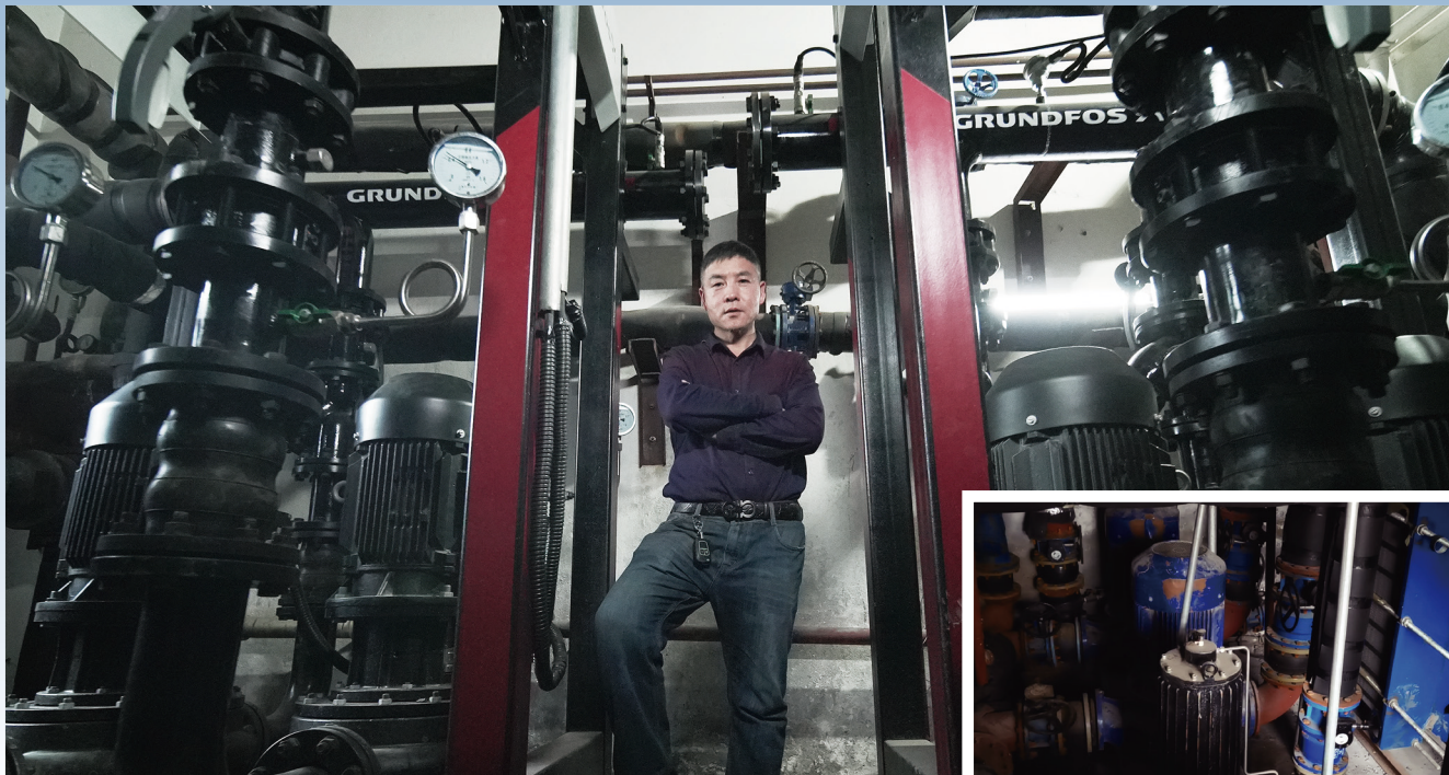
(山西杰灵热力换热站狭小的装配空间)
